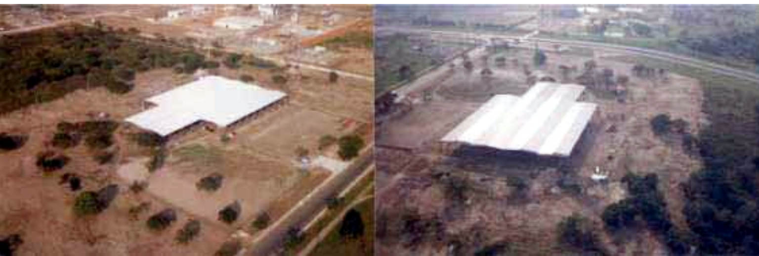
Panorámica del proceso de construcción del Parque Internacional del Cebú
