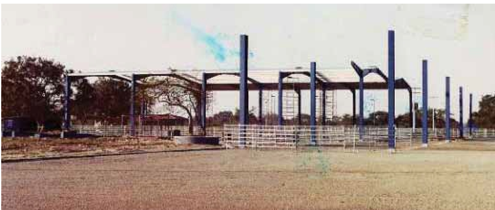
Aspecto de la construcción de la nave principal del PIC que comprende una superficie de más de una hectárea
